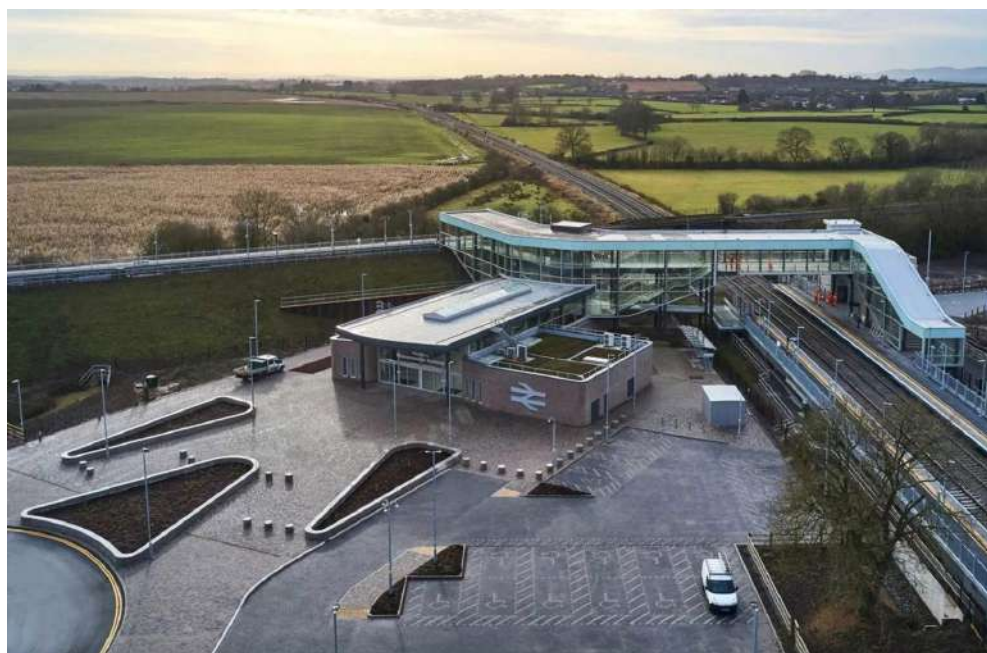
Рис. 11. Worcestershire Parkway – станция, построенная по схеме BREEAM Infrastructure: в качестве стальных свайных фундаментов по всей площадке были использованы специально обработанные нефтяные трубы. (Источник: https://bregroup.com/case-studies/worcestershire-parkway-regional-interchange )
