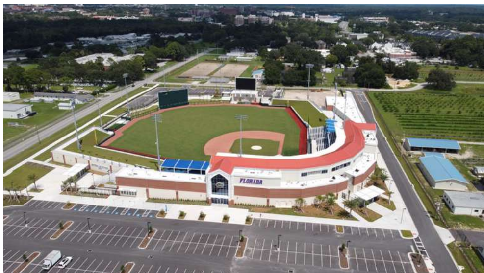
Рис. 34. Condron Family Ballpark (г. Гейнсвилл, Флорида). (Источник: https://ballparkdigest.com/2022/04/24/new-for-2022-condron-family-ballpark )
