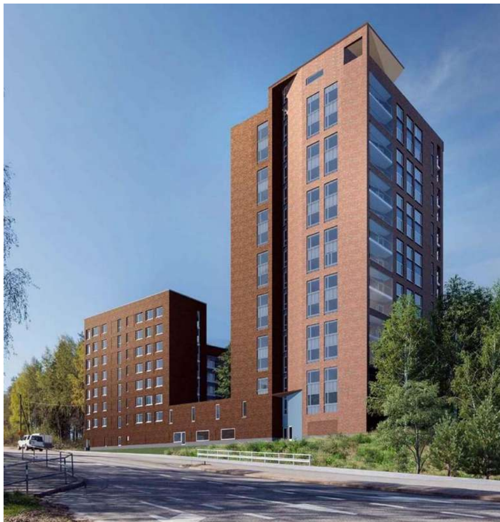
Рис. 43. Здание, сертифицированное по «зеленой» программе RTS (Финляндия). (Источник: https://rakersystems.fi/en/municipalities-and-property-developers/environmental-certifications-for-construction-projects/ )
