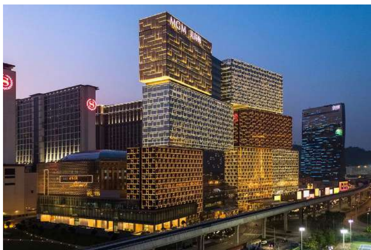
Рис. 21. MGM Cotai. Avenida da Nave Desportiva, Macau, China. Уникальная система освещения комплекса оборудована 48 тыс. специальных светильников, чтобы подчеркнуть различные узоры фасада. Система управления позволяет сбалансировать интенсивность отдельных устройств для равномерного освещения архитектурных элементов. Астрономические часы синхронизируются с изменением времени восхода/захода солнца в течение года, обеспечивая экономию энергии. Индивидуальное управление приборами позволяет отображать на фасаде даже видео. (Источник: https://www.kpf.com/project/mgm-cotai )
