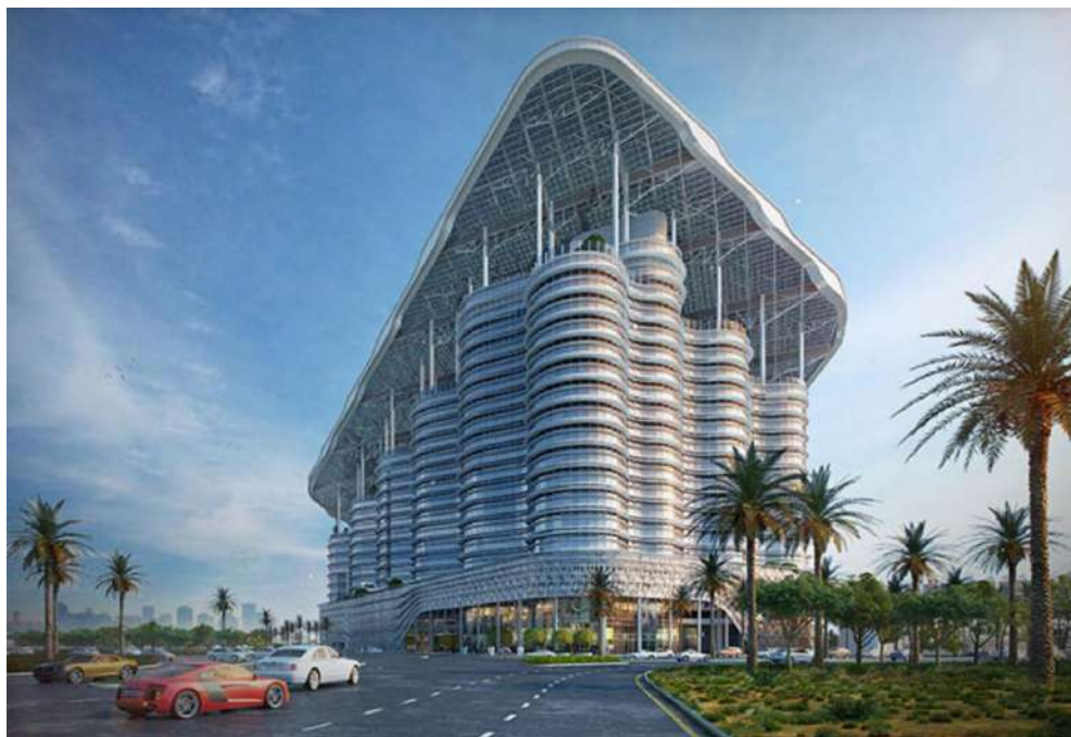
Рис. 5. DEWA Al Sheraa в Дубае. Здание напрямую соединено мостом со станцией метро Jadaf, что стимулирует использование общественного транспорта для уменьшения трафика и углеродного следа. (Источник: https://www.dewa.gov.ae/en/about-us/media-publications/latest-news/2019/10/dewa-awards-contract )
