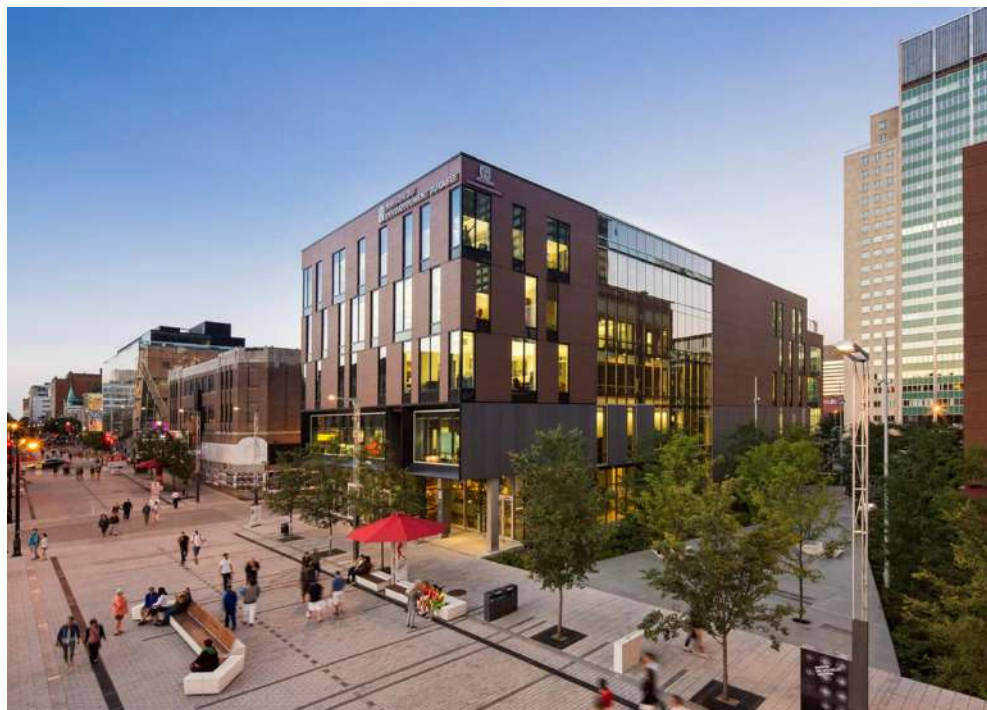
Рис. 32. Здание Центра устойчивого развития (г. Монреаль, Канада). (Источник: https://divisare.com/projects/241310-Menk-s-Shooner-Dagenais-LeTourneux-Architectes-Maison-du-d-veloppement-durable )
