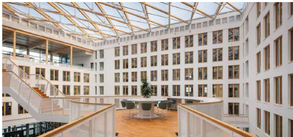
Рис. 14. Комплекс EDGE Suedkreuz (Берлин), получивший выдающийся рейтинг DGNB. Обе конструкции возведены из перерабатываемой древесно-гибридной системы. Выбор строительных изделий более чем наполовину определяет оценку производительности проекта. (Источник: https://edge.tech/de/developments/edge-suedkreuz-berlin )
