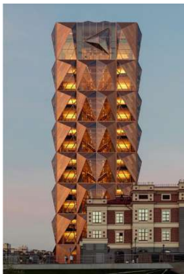
Рис. 56. Штаб-квартира Русской медной компании (13,5 тыс. м 2 ), сертифицированная по протоколу GREEN ZOOM (здание имеет неофициальное прозвище «Ананас»). (Источник: https://krasivoe-foto.ru/photo/здание-рмк-в-екатеринбурге-фото/ )
